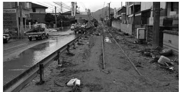
写真4 被害状況4 土砂で埋まったJR可部線
