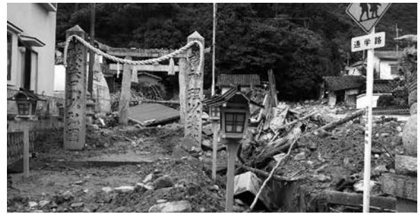
写真2 被害状況2 神社の入り口
