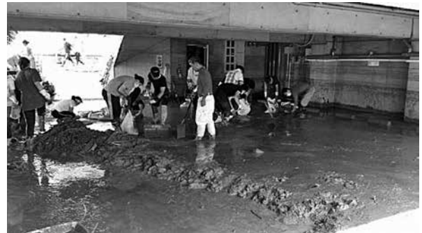
写真10 動物病院駐車場の状況 泥流が駐車場壁面高さ約160cmまで侵入した跡が観察される(被災後2日目)
